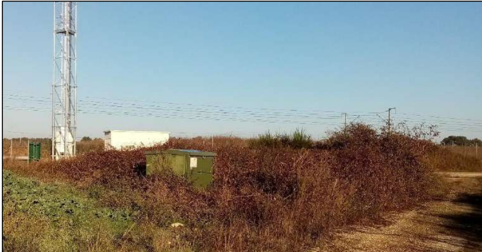
Figure 56 : Poste de transformation et site radioélectrique près du site d'étude (Crédit photo : NCA Environnement, octobre 2021)
