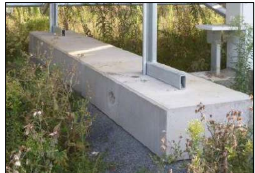
Figure 28 : Types de fondation - semelle béton
