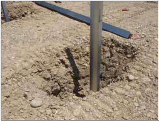
Figure 27 : Types de fondation - pieux battus
