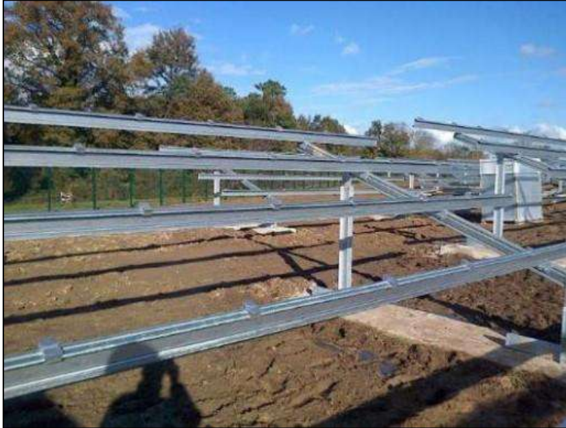
Figure 33 : Exemple de chantier de construction – Pose des structures (Source : SERGIES, 2015)
