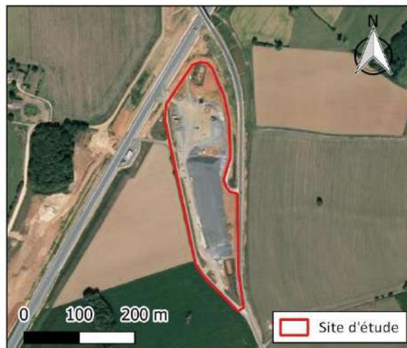
Figure 17 : Photographie aérienne du site en 2014 pendant le chantier de la LGV SEA (Source : IGN)
